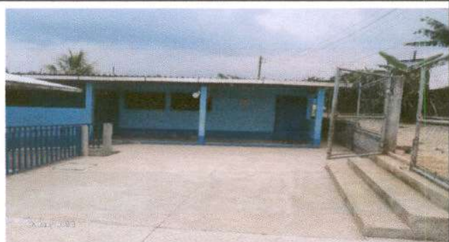
Foto1: Sustrucción de lámina por lámina troquelada aluzinc calibre 26 80 M2
